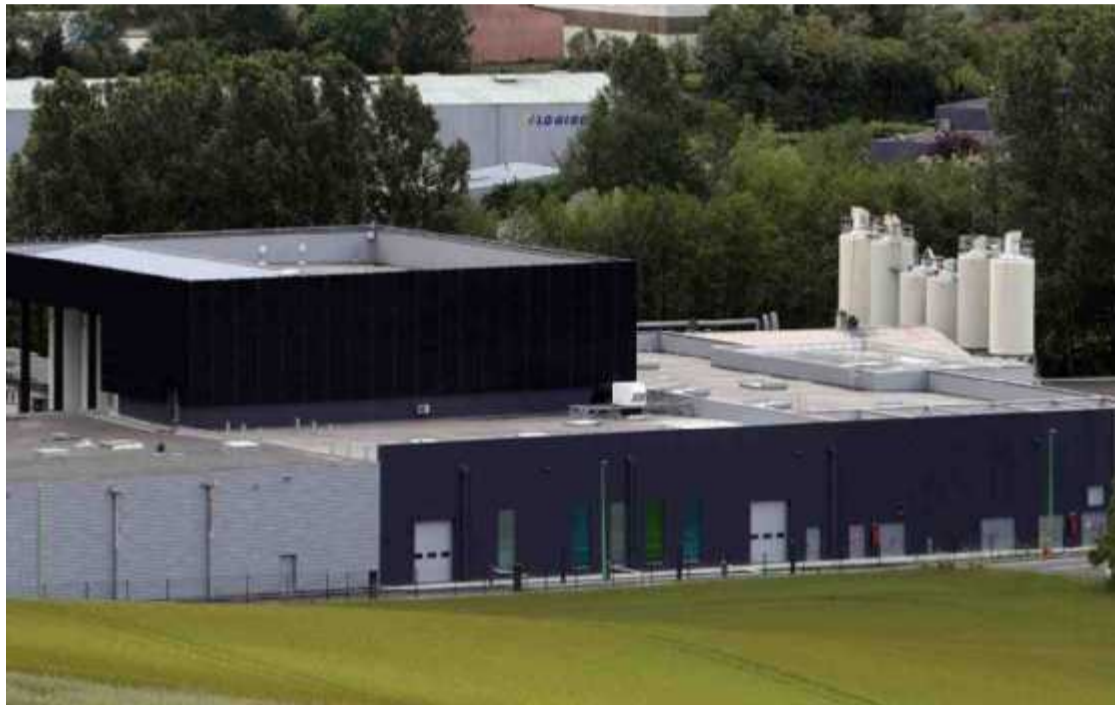
Ce nouveau site sera inauguré vendredi. PHOTO THIERRY SUIRE
